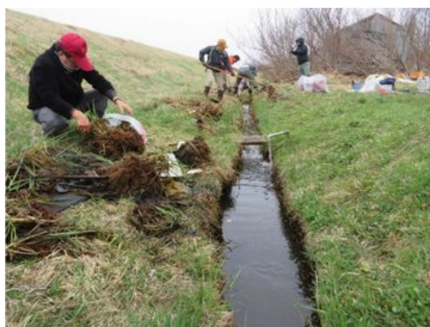
A. 清掃作業の様子。
