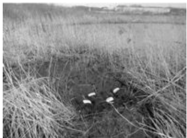
D. カゴ罟の設置風景（海岸道路側）
