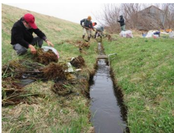
A. 清掃作業の様子。
