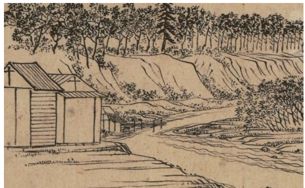
図10. (同左) 右岸の建物付近。
