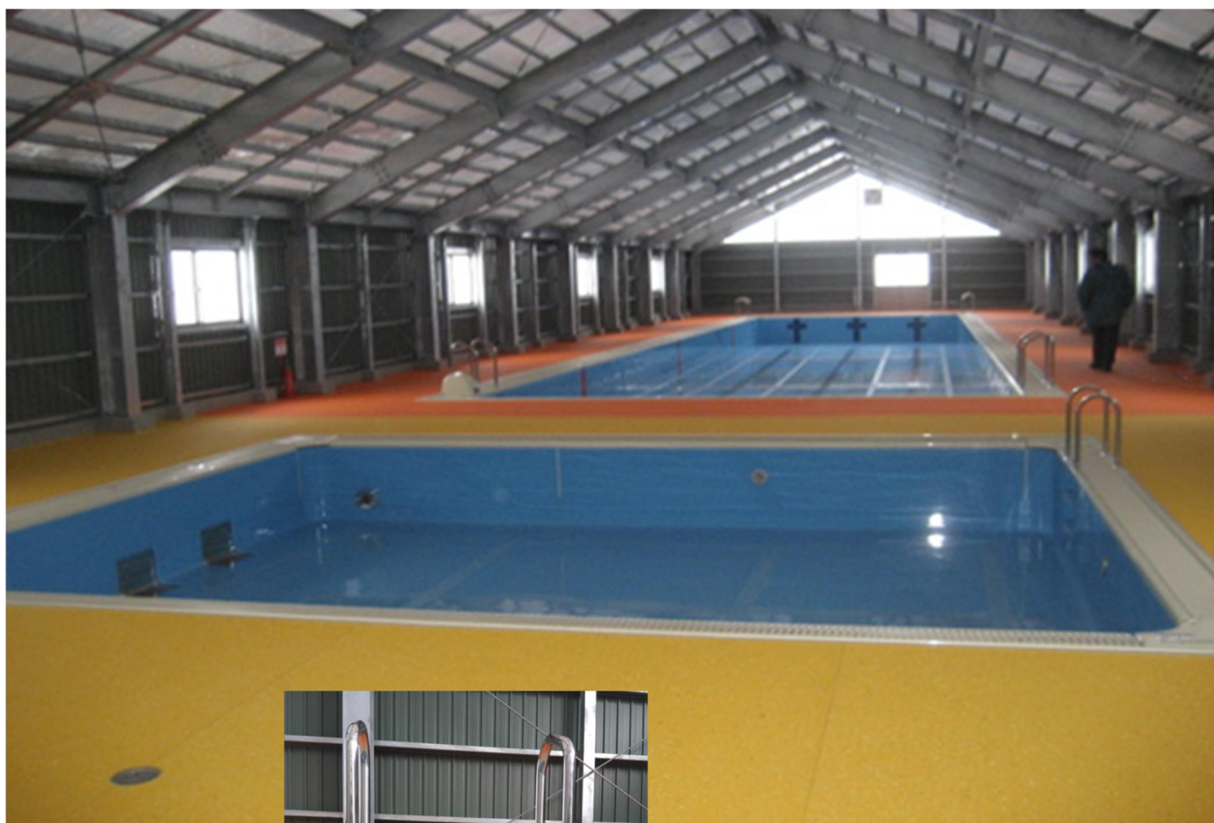
■手前が幼児用プール5m×6m（水深70センチ）、奥が一般用プール
