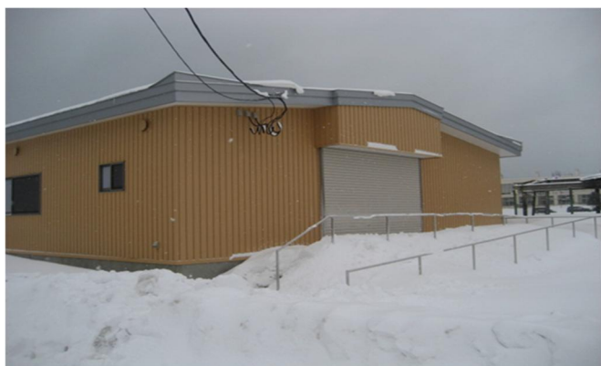
■正面入口（右側に伸びる手すりはスロープ部分）
