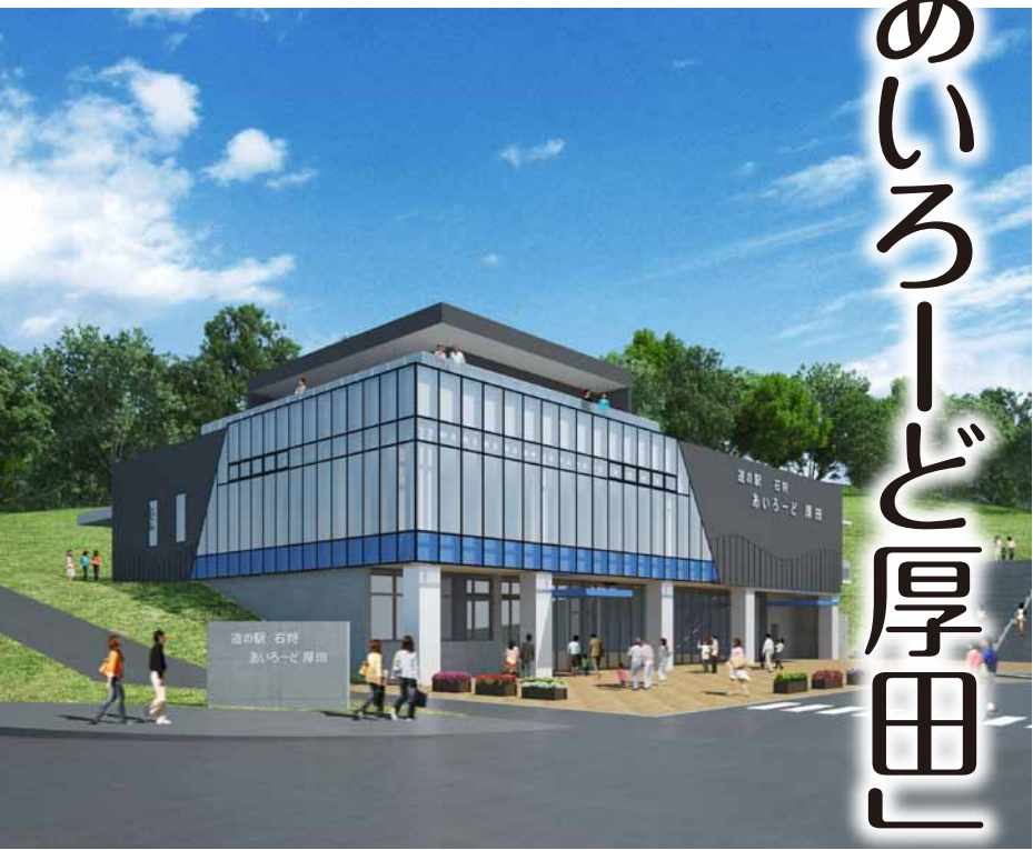
道の駅には珍しい鉄筋コンクリート造り3階建てで、延べ床面積1,333㎡。日本海が眺望できるガラス張りにこだわりました。ちなみに、この角度から見る建物は、航海する北前船をイメージしています。
