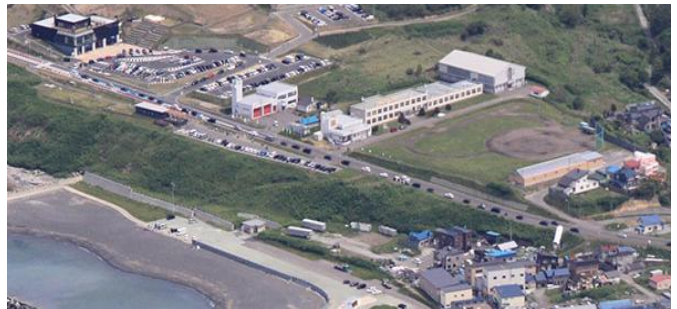
道の駅「あいろ一ど厚田」(左上)～旧厚田中学校校舎～新しくできた「厚田小学校プール(右側)」の全景
