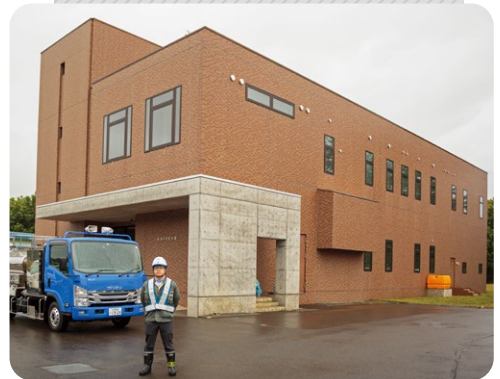
▲新港中央配水場
