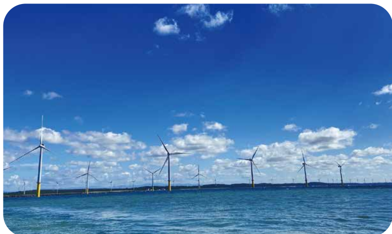
秋田県にある全国初の洋上風力発電所(能代市提供)
