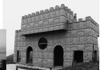
厚田公園展望台は国道231号から姿を確認することができます
