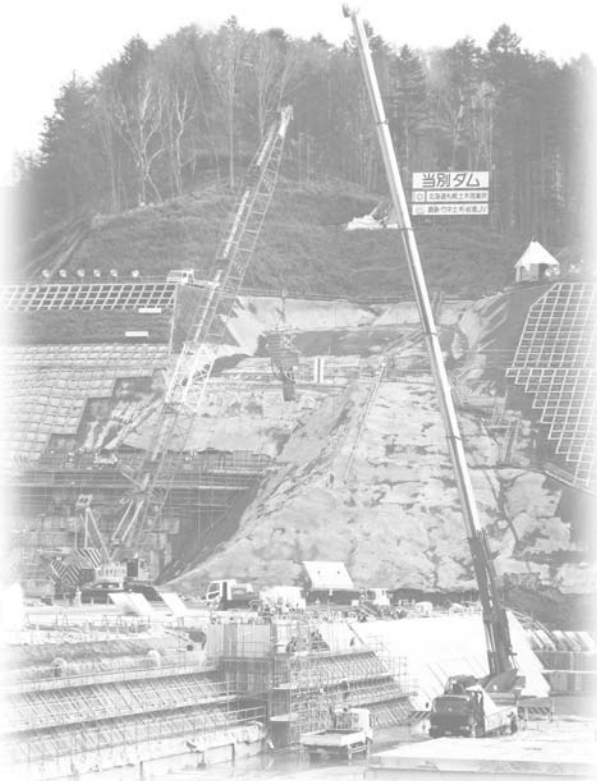
建設が進む当別ダム
