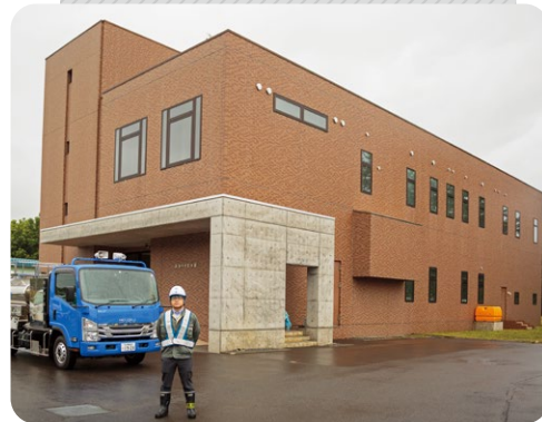
▲新港中央配水場
