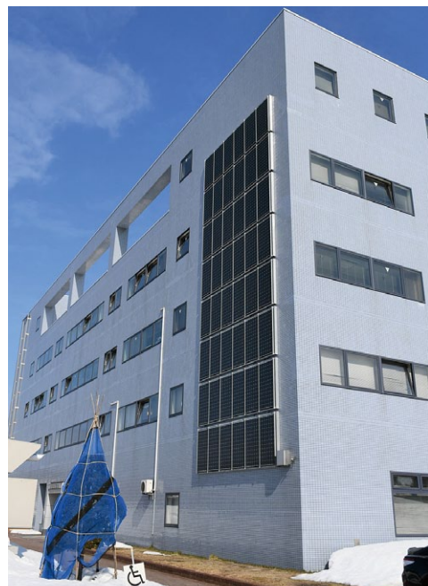
市役所に設置している太陽光パネル
