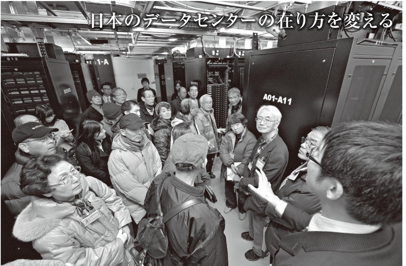
▲写真奥に見えるたくさんの棚がサーバーラック。1棚は約30台分のコンピューターに匹敵し、電気ストープ6台分の熱が発生します。そのため都市型データセンターでは大型クーラーが必須ですが、ここでは冷涼な外気を取り込み調整するため環境にもやさしい。
