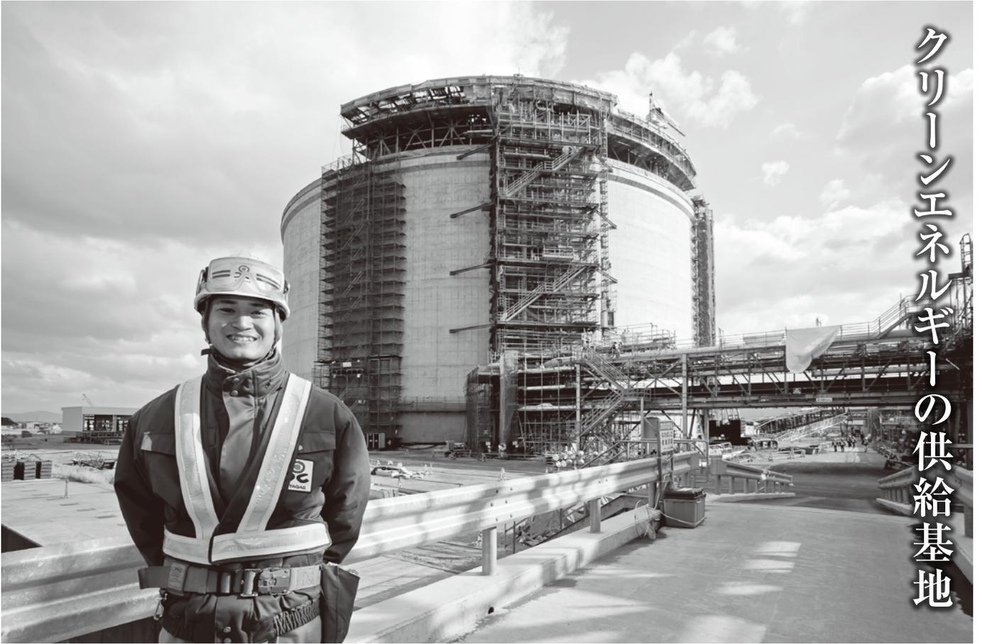
▲最大18万キロリットルの容量を持つ巨大なLNGタンク。外は丈夫なコンクリート、中は金属を二重にした構造を持ち、LNGと接する内槽は9%ニッケル鋼という低温に強く、さびが生じない特殊な合金で造られています。
