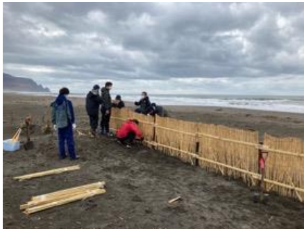
写真：堆砂垣の設置の様子
