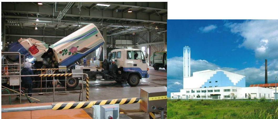
写真：北石狩衛生センター
