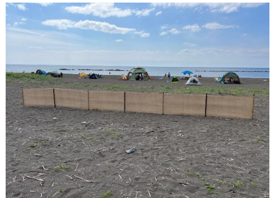
写真：設置した堆砂垣
