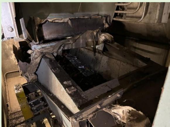
写真：爆発で各種機器が破損している様子
