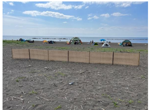
写真：設置した堆砂垣
