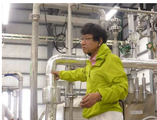
●超電導直流送電システムの実証研究施設の説明
