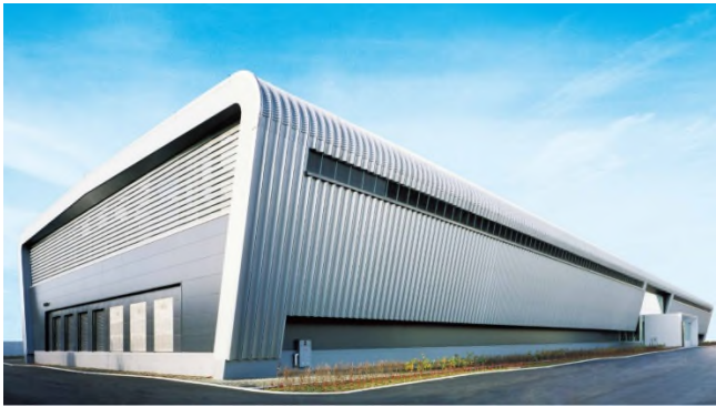
データセンター外観
