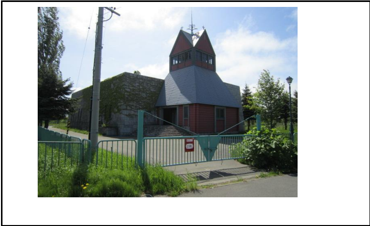
建屋正面（左前方から）
