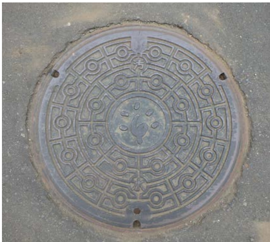
汚水マンホール
