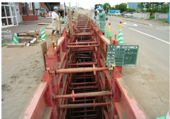
污水管渠工事
