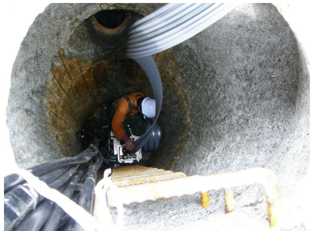
汚水管渠更生工事
