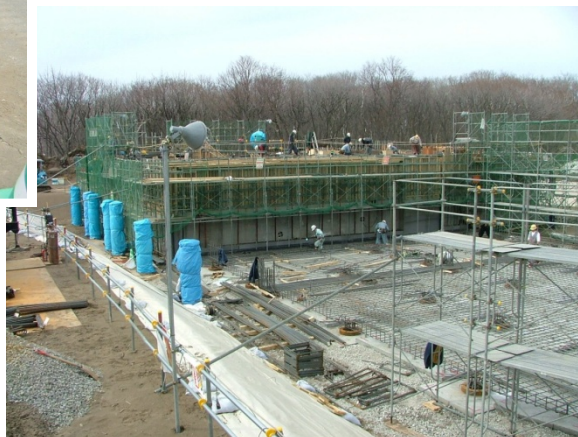
八幡処理場 建設工事
