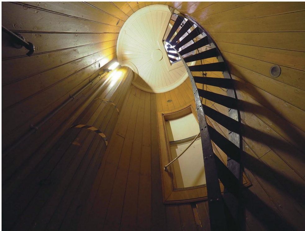
2階から3階へつづく鉄の階段。天井の意匠も美しい。壁の盛り上がっている所（左側）が分銅筒
