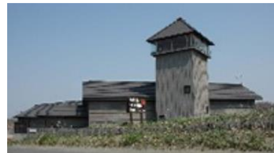
石狩浜海浜植物保護センター
