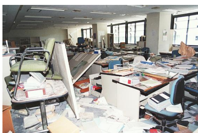
①神戸市役所の執務室の状況
