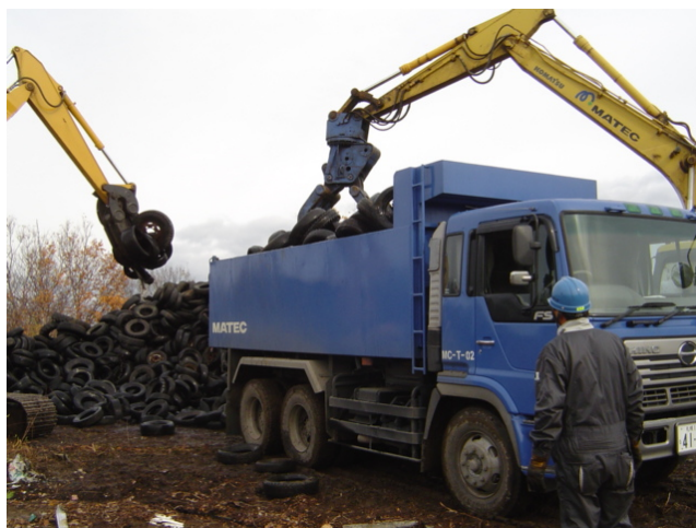
厚田区望来の廃タイヤ撤去
