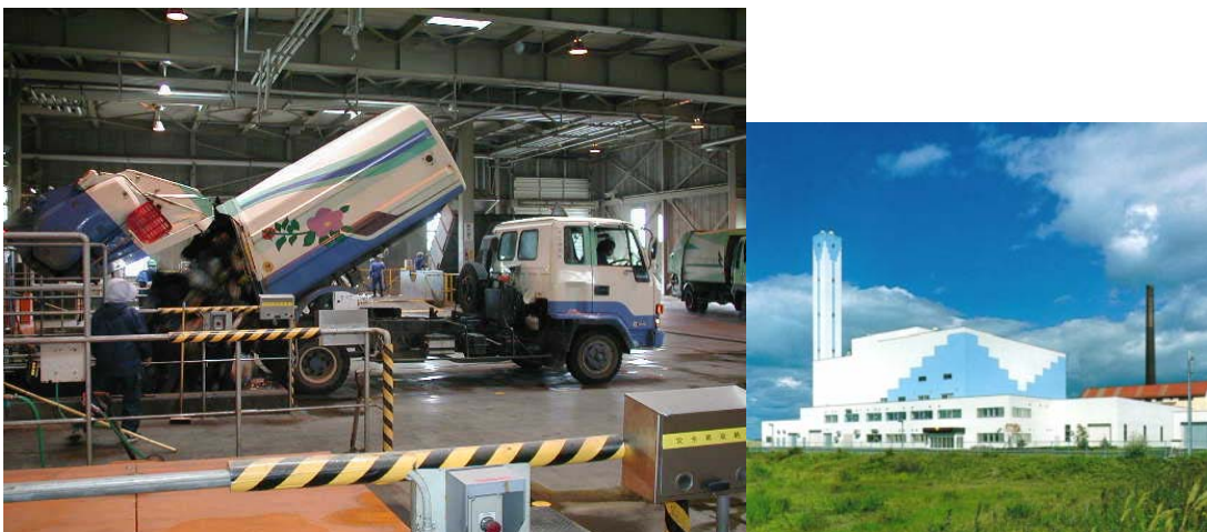
北石狩衛生センター
