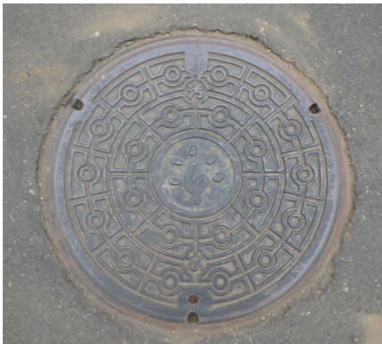
汚水マンホール
