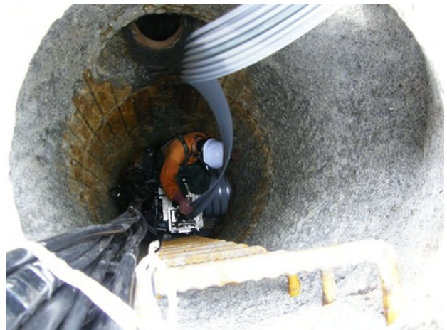
汚水管渠更生工事
