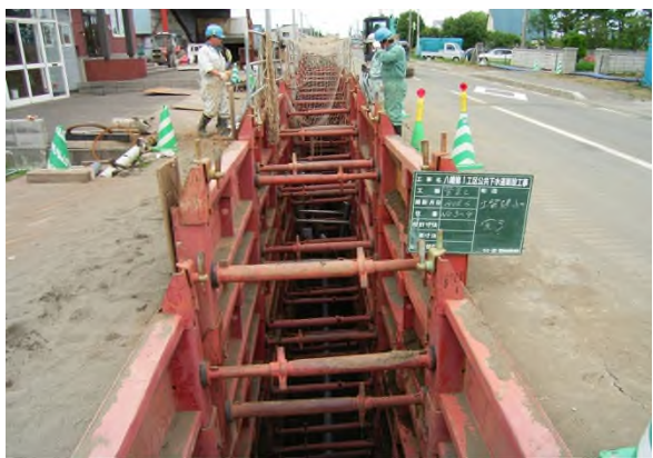
污水管渠工事
