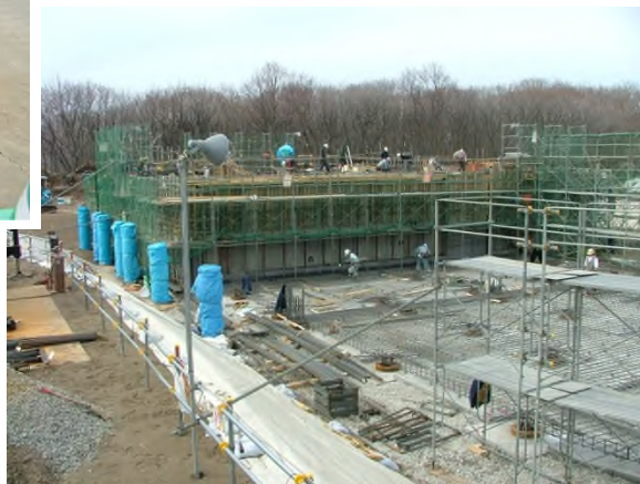
八幡処理場 建設工事
