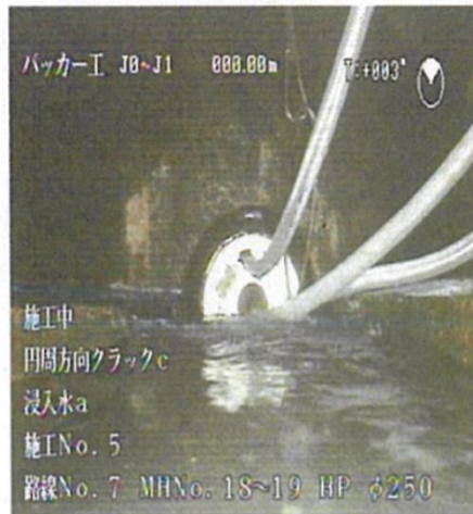
施工中(直視) (クラックに薬剤注入)
