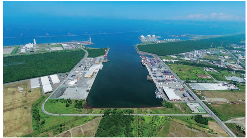
石狩湾新港の掘込み水路
