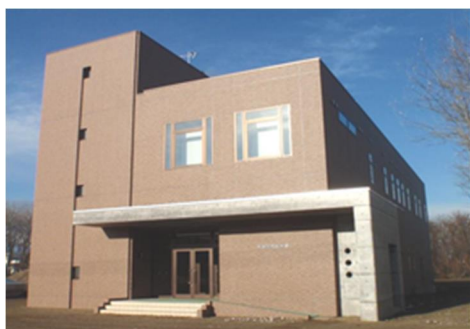
新港中央配水場
