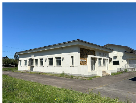
花川北配水場
