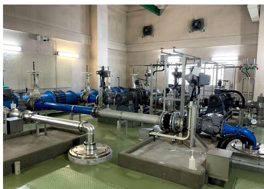
写真6－2 更新された配水ポンプ及び計装盤
