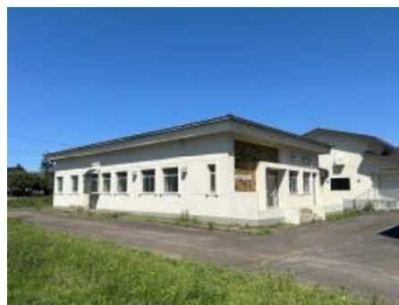
花川北配水場
