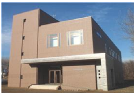
新港中央配水場
