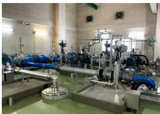
写真6－2 更新された配水ポンプ及び計装盤
