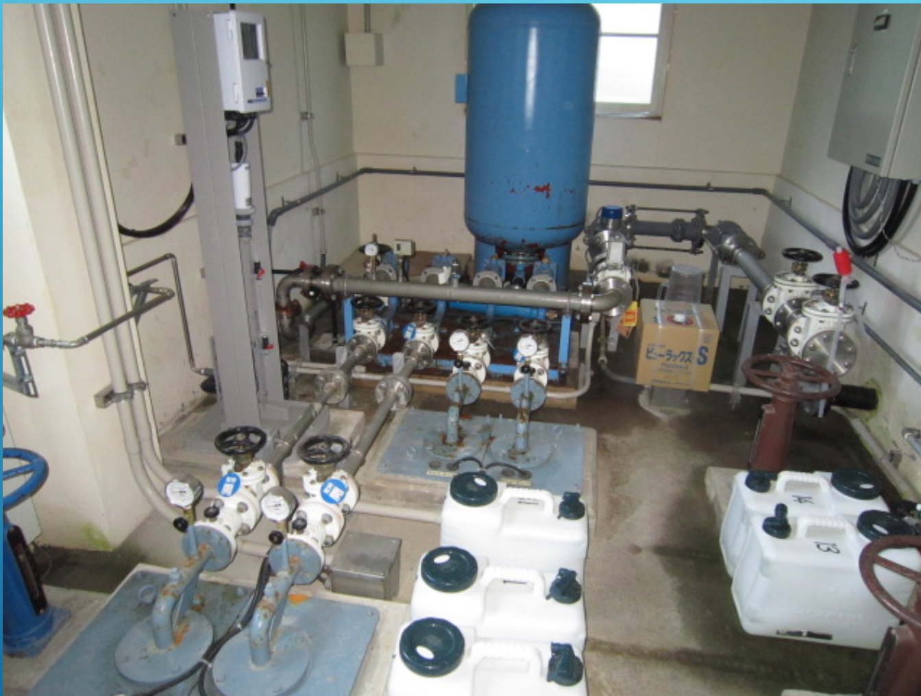
濃昼浄水場圧力タンク 1975年設置（41年経過）
