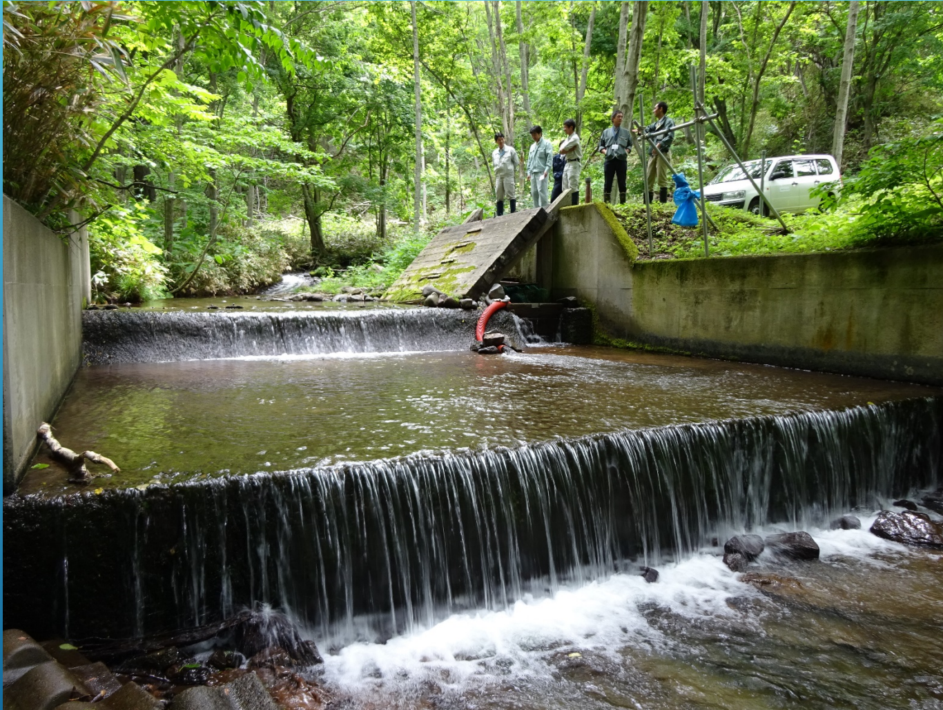
厚田浄水場取水施設 現地老朽度調査状況
