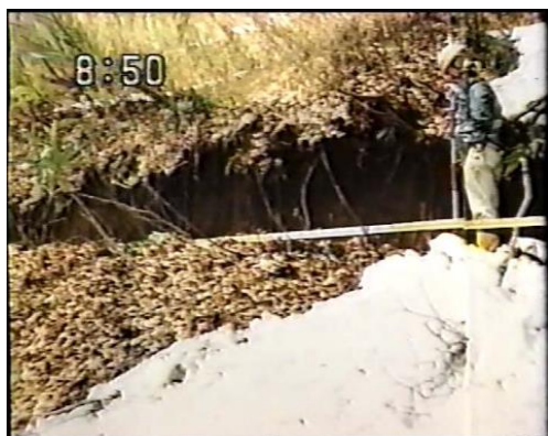
斜面のひびが進行してできた段差
