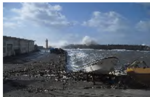
写真-13 港内への越波（浜益漁港）
