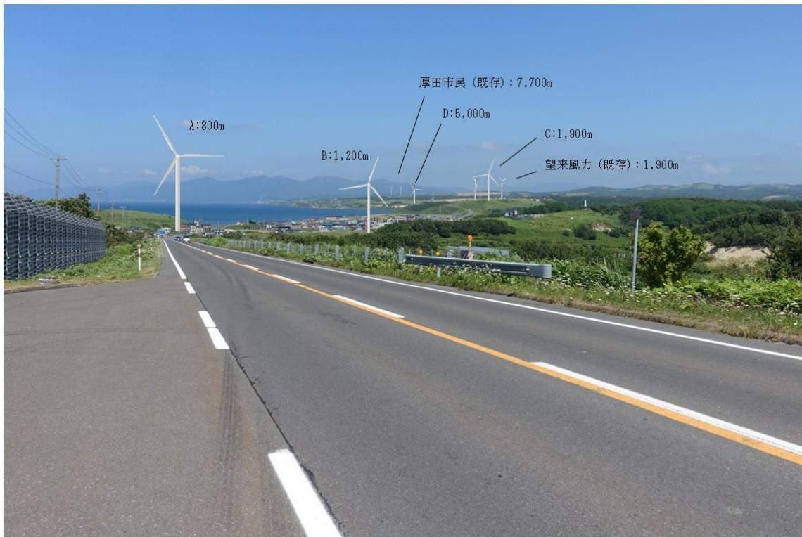
眺望位置：厚田区 望来坂 道路端駐車スペース      風車諸元（ハブ高 84m 最高到達高さ 140m） 写真画角 60°
