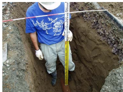
写真-2 管布設状況（緑ヶ原）
