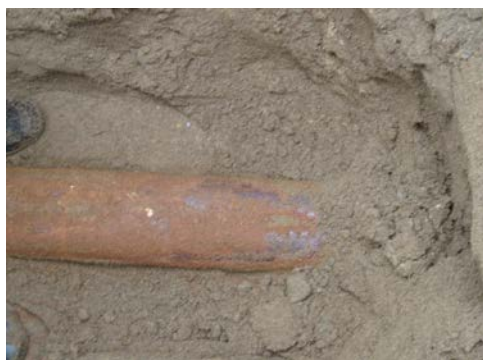
写真-1 管体状況（緑ヶ原）
