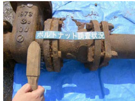
写真-12 ボルト・ナット調査
