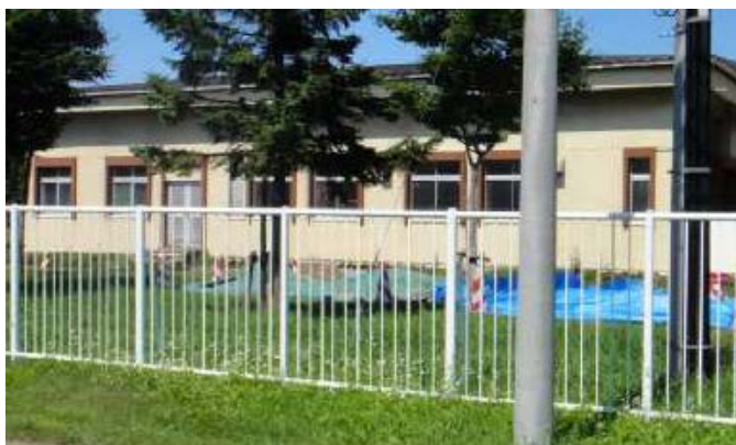
写真-16 花川北配水場
