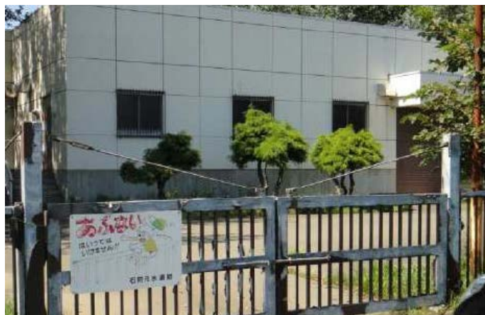
写真-17 新港中央配水場
