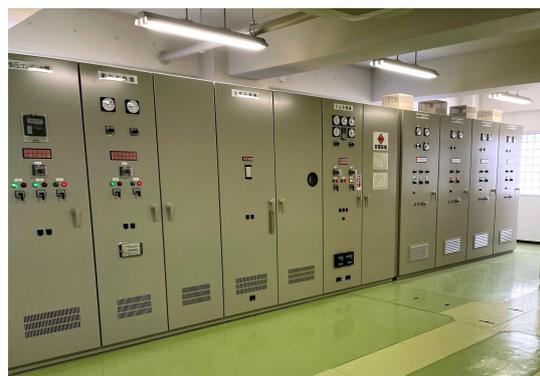
写真6-2 更新された配水ポンプ及び計装盤
