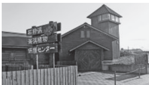
▲石狩浜海浜植物保護センター
