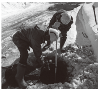
下水道管の腐食調査▲▶
