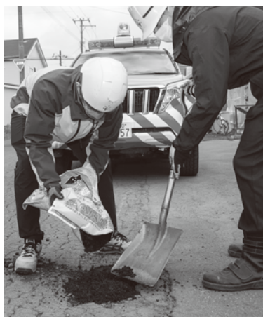
▲危険な穴を埋める作業の様子
