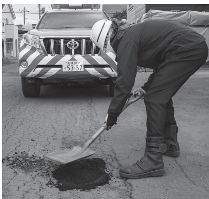
▲道路パトロールで補修する様子
