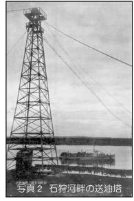
この年、同社は軽川(手稲)駅隣に、敷地約19haの「北海道製油所」を建設しました。油田から石狩川河畔(来札)までパイプ油送、石狩川の渡河は長い間、艀を使用しました。昭和3(1928)年、空中にワイヤロープを張り、石狩川を渡河させました(写真2)。油田から精製工場まで約30kmをパイプライン(原油は直径約5cm、ガソリンは3.3cmパイプ)で結び、全区間の流送が可能となりました(この製油所は昭和20(1945)年7月20日、米艦載機の空爆、石油タンク7基と工場焼失)。
