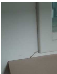
↑ 図書館事務室 窓枠近辺のひび割れ
