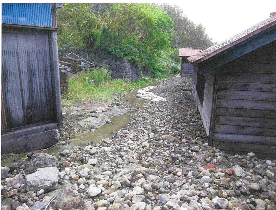
資料館裏に堆積した土砂
