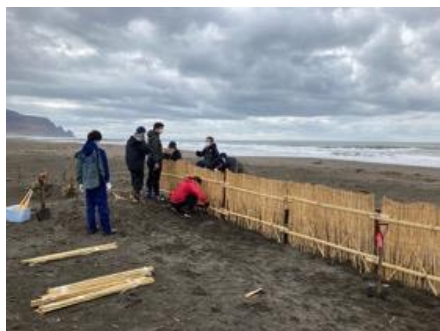
写真：堆砂垣の設置の様子
