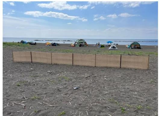
写真：設置した堆砂垣
