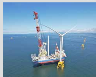
▲洋上風力発電機本体の建設工事の様子
