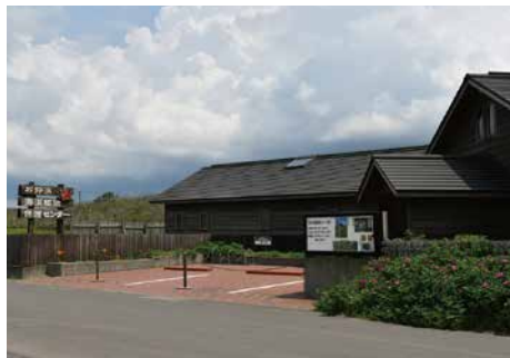
石狩浜海浜植物保護センター
