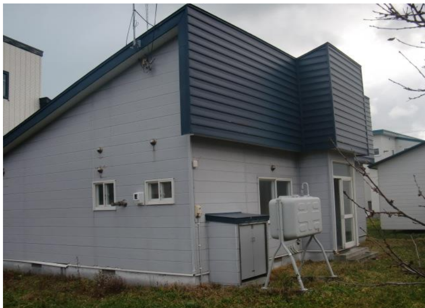
職員住宅 正面側
