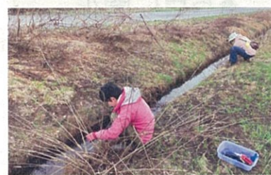
側溝水路の清掃作業
