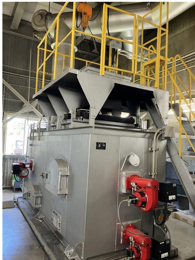
図 6-5 既存小動物焼却施設の外観
