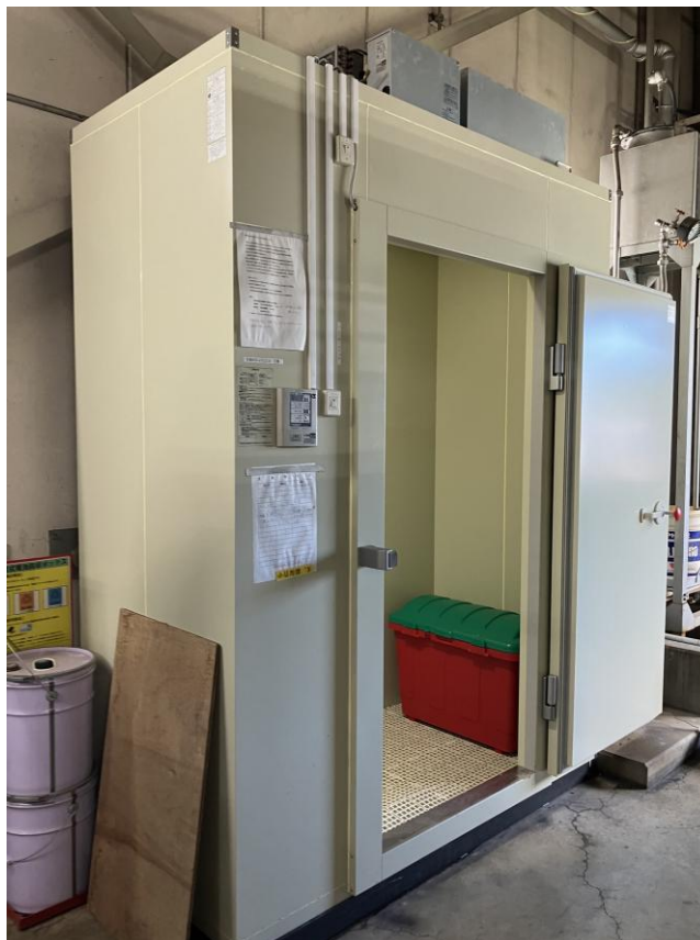
図 6-6 既存小動物焼却施設に併設されている冷蔵庫
